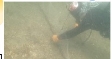
ウニフェンス設置
