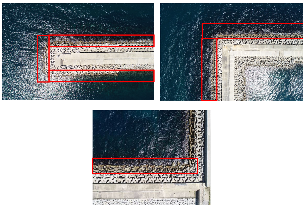
図-5 ドローンによる空撮写真 ( 上段：堤頭部 、下段：北護岸端部)
