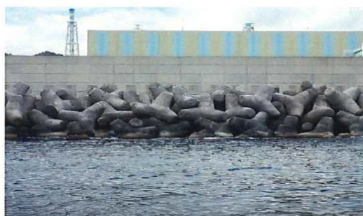
調査測線 4 基点
