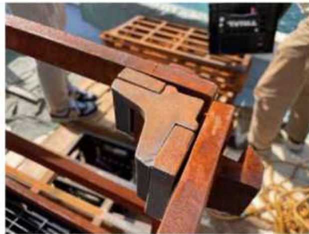
水中でも作業しやすい独自開発のくさび
